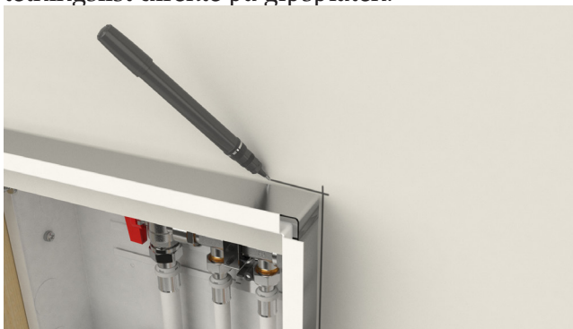
Marker rammens utside på gipsplaten.
